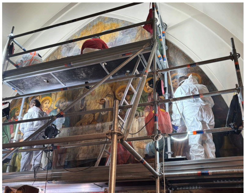
Début des travaux
